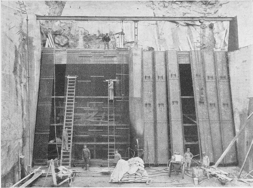
Abb. 8. Der Einlauf am Weisssee, links Rechenmontage, rechts „Dambalken“-Tafeln.
