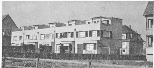
Abb. 10. Bau auf Abb. 6 von vorn gesehen. Jedes Haus hat seinen sonnigen, ruhigen und einblicksfreien Dachgarten. Ausnahme-Bewilligung.
