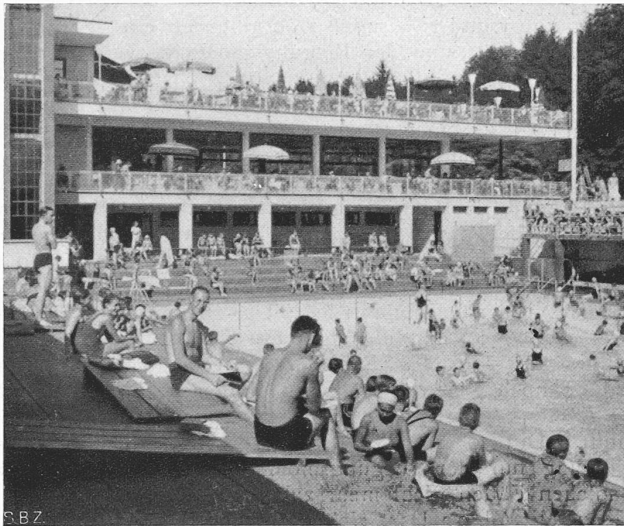
Abb. 7. Schwimmbad, gegen das Terrassen-Restaurant (gegen Osten).
