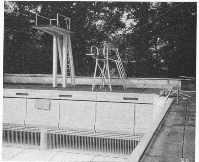
Abb. 12. Wellenaustritt am Tiefende des Schwimmbeckens.
