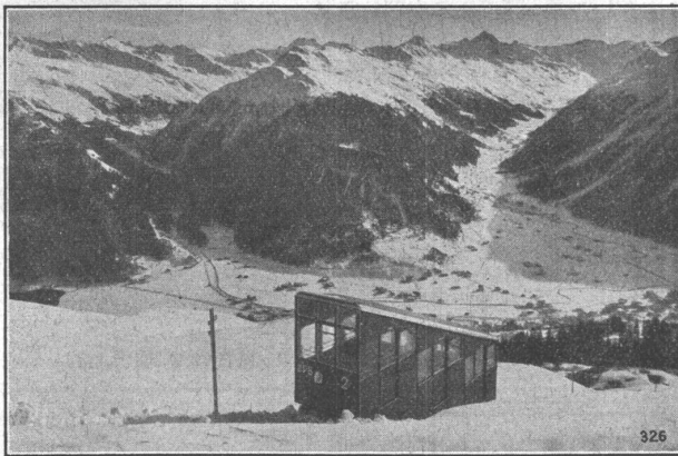
Seilbahn Parsenn, Davos, gebaut in zwei Sektionen von 1200 und 1893 m Länge.
