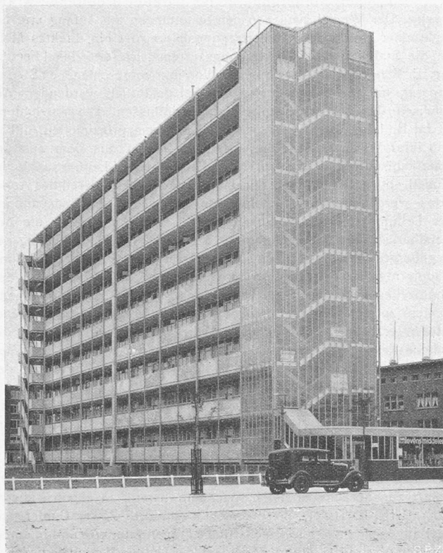
Abb. 10. Nördliches Treppenhaus und Laubengänge der Ostfront.
