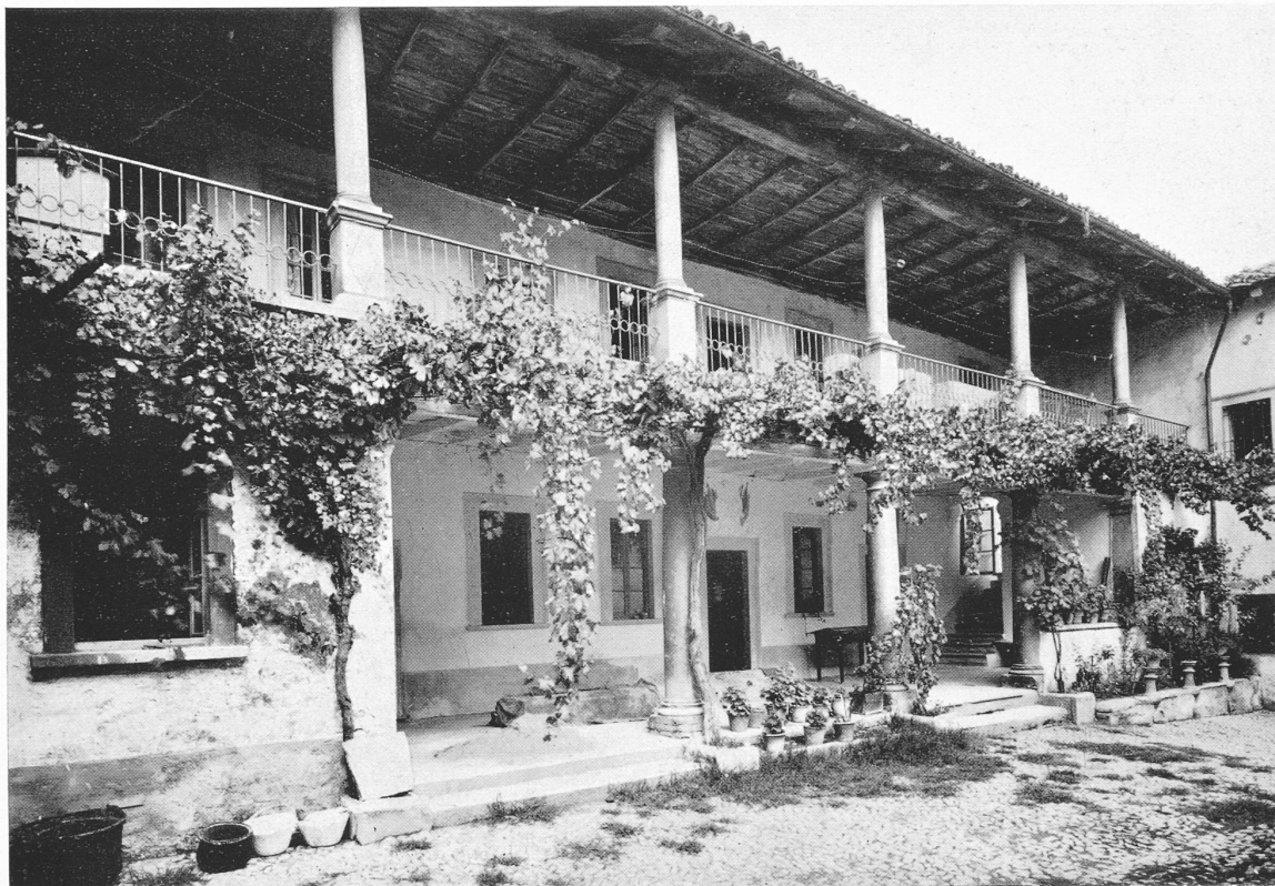
Abb. 1. Meride, Casa Oldelli. — Loggia am Vorplatz gegen die Strasse.
