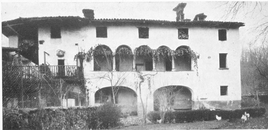
Abb. 12. Casa Perini in Magliasina (zwischen Magliaso und Ponte Tresa).
