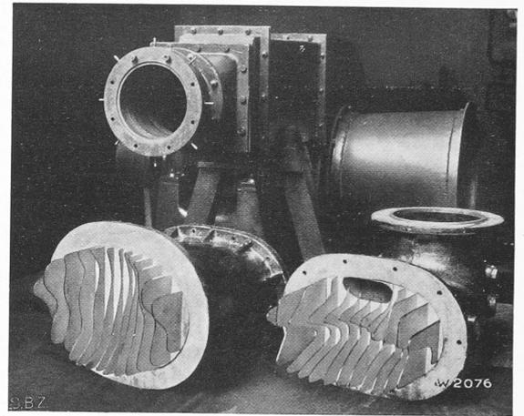
Abb. 21. Modelle der Geschwindigkeitsverteilung am Austritt von Wasserturbinen-Saugrohren. Im Modell rechts gibt der schwarze Fleck ähnlich wie bei Abb. 20 das Gebiet des Rückströmens.
