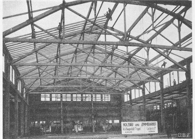
Abb. 10. Montage des hölzernen Hallendaches.
