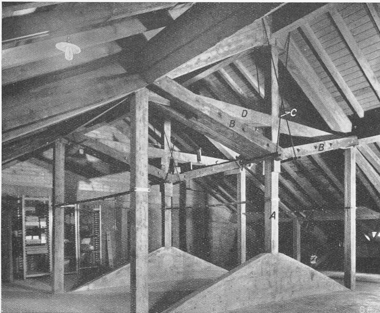
Abb. 3. Die Spannvorrichtung, letzter Riegel noch nicht ausgeschalt (20. Sept. 1934).
