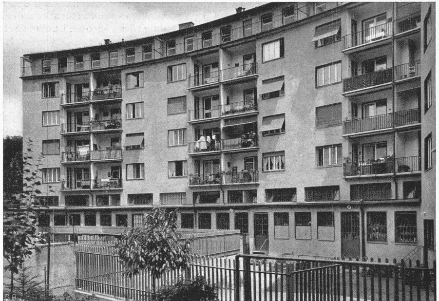
Abb. 3. Hofseite des Hauptflügels. Die breiten Fenster belichten die innern Lagerräume (Schnitt C-D).
