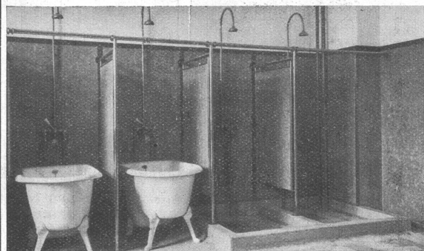
Graue Eternitplattenverkleidung eines Duschenraumes.
