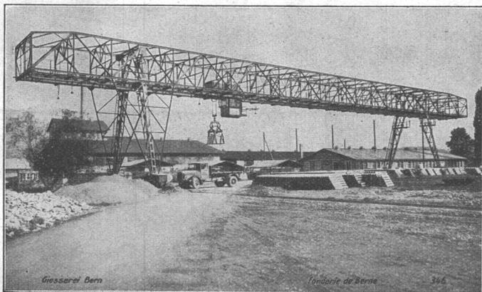
Verladebrücke, totale Brückenlänge 73,5 m, Spannweite 50 m, Tragkraft 6,5 t,
