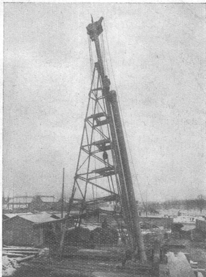
Verwendung von Stahldrahtseilen in Rammen.
