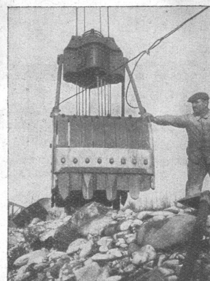
Verwendung von Stahldrahtseilen in Greifbaggern.
