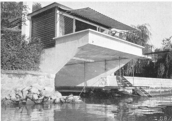
Abb. 55. Blick ins Boothaus unter der vorkragenden Terrasse.
