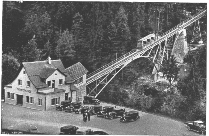
Drahtseilbahn Schwyz-Stoos, Talstation mit der Brücke über die Muotaschlucht (Brücke ebenfalls von uns geliefert).
