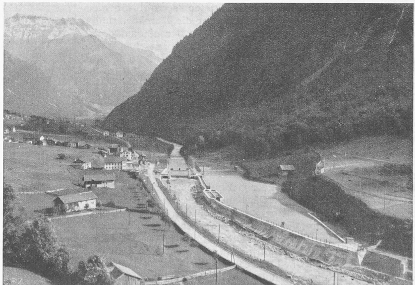
Abb. 3. Wasserfassung des Sernfwerkes, taleinwärts gesehen.
