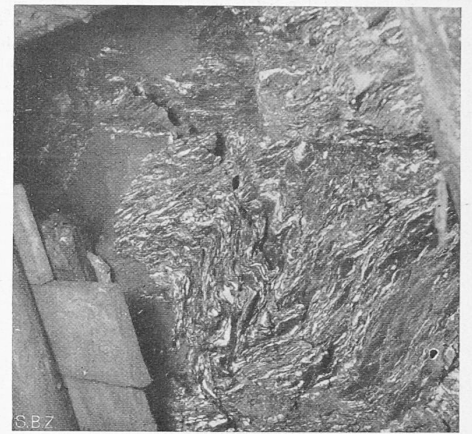
Abb. 6. Stark gefalteter Flysch im Sernfstollen, oben links Verrucano (15. Dez. 1930).
