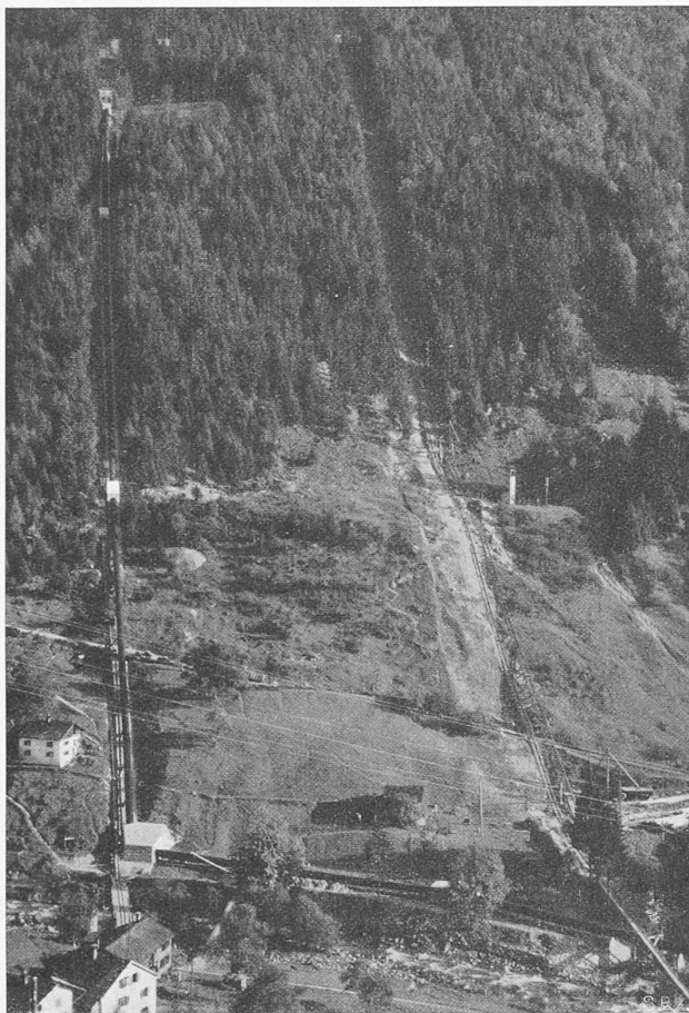
Abb. 20. Druckleitungen: links vom Sernf, rechts vom Niederenbach-Werk.
