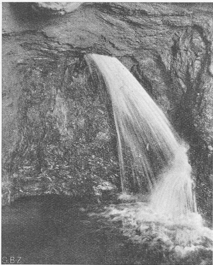
Abb. 14. Wassereintrich von rd. 1000 l/min 103 m abwärts von WP II gegen WP III.
