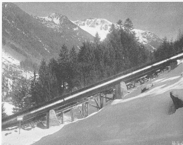
Abb. 21. Kreuzung des Suwarowweges durch die Sernf-Druckleitung.
