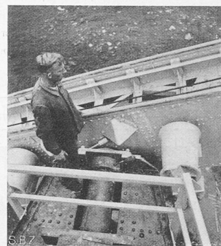
Abb. 10. Auflagerachse eines drehbaren Seilschuhes, Stütze 1.
