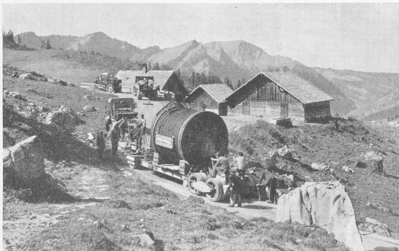
Abb. 18. Transport der 35 t-Seiltrommeln auf 17% Steigung durch die Welti-Furrer A.-G., Zürich.
