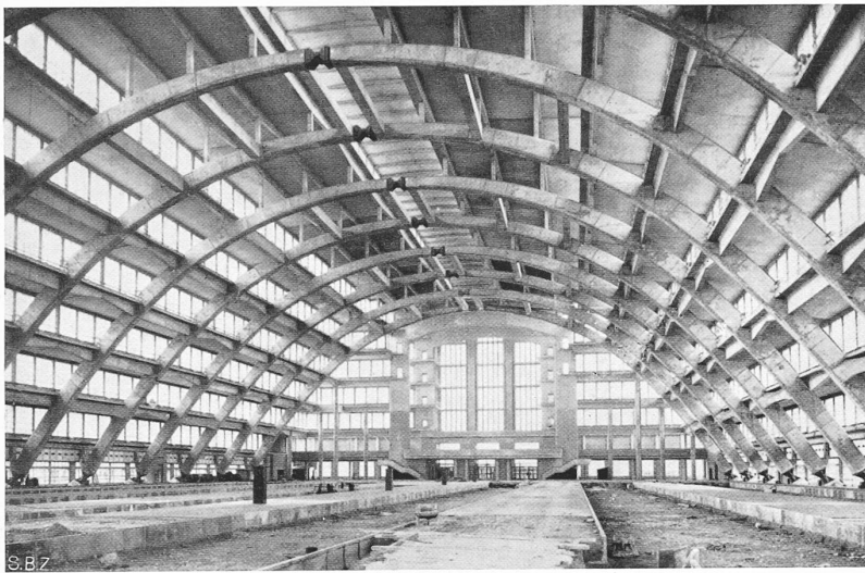
Abb. 2. Halle des „Grand Palais“ für die Eisenbahnfahrzeuge.
