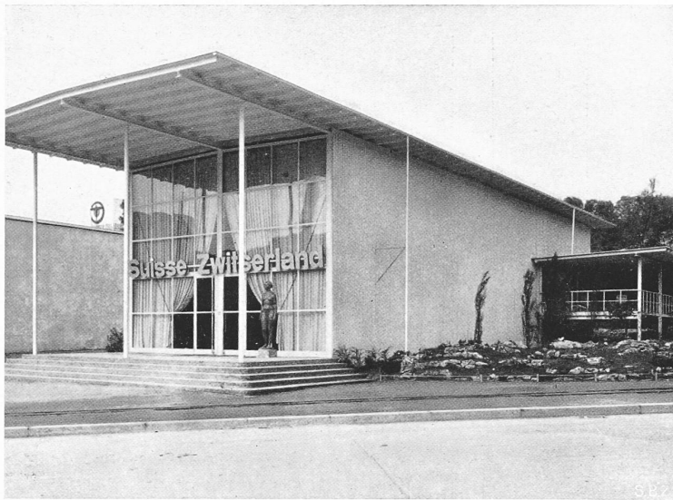
Abb. 11. Die Urennhalle, die den untern Eingang zur Schweizerabteilung bildet. Rechts Austritt von der Galerie auf den Verbindungsgang.
