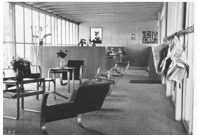
Abb. 16. Schreib- und Lesesaal, im Hintergrund das Ausstellungs-bureau, rechts Ausgang zur Maschinenhalle.
