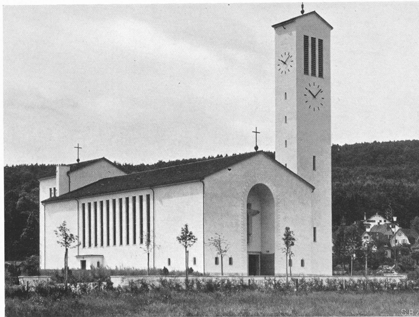
UNTEN AUS NORDEN, OBEN AUS NORDWEST MIT PFARRHAUS UND SAKRISTEI
