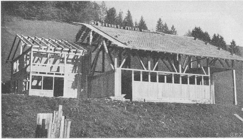
Abb. 6 und 7. Verschiedene Bauzustände. Man beachte die gute Belichtung des Stalles durch die hochliegende Fensterreihe.
