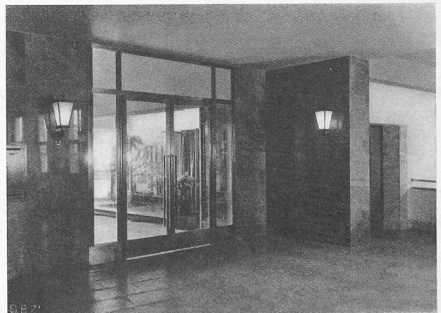
Abb. 21. Eingang vom Viadukt zum Restaurant (III. Stock).
