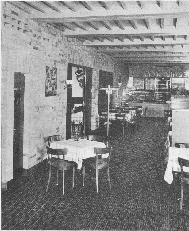
Abb. 25. Rückwand der Bierhalle, Fussboden in Holzmosaik-Parkett.
