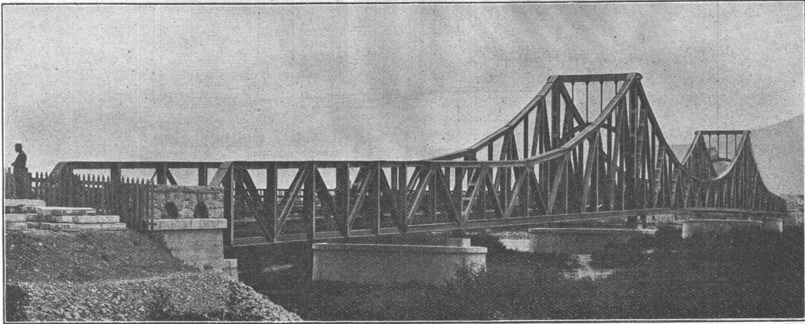
Strassenbrücke Diepoldsau. — Gesamtlänge 251,2 m; Stützweite der Mittelöffnung 92,5 m; Breite 7 m; Gewicht der Eisenkonstruktion ca. 870 Tonnen
