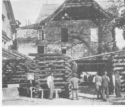
Abb. 2 und 3. Das Haus während der Längsverschiebung über der Strasse, von Westen gesehen.
