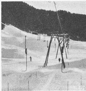
Abb. 1. Tiefhängende Schleppbügel an der untern Station.
