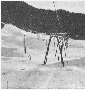
Abb. 1. Tiefhängende Schleppbügel an der untern Station.
