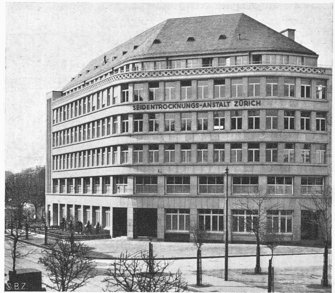
Abb. 3. Nordansicht von der Alfred Escherstrasse aus.
