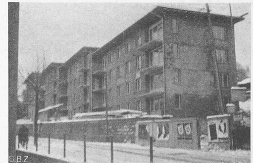
Kellermüller & Hofmann, Arch. BSA, Zürich. Wohn-Kolonie Oeristeig Zürich (ABZ).
