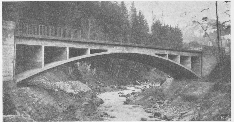
Abb. 3. Spitalbrücke über die Engstligen; Staatstrasse Frutigen-Adelboden.
