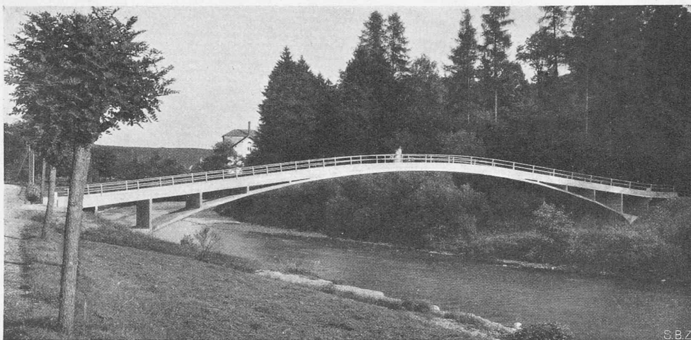
Abb. 1. Fussgängersteg über die Töss bei Wülflingen. Spannweite rd. 40 m, Bauzeit 2 Monate.
