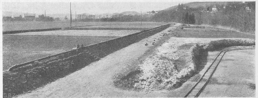
Abb. 11. Schlammteichanlage (im Hintergrund links das Gaswerk Schlieren).
