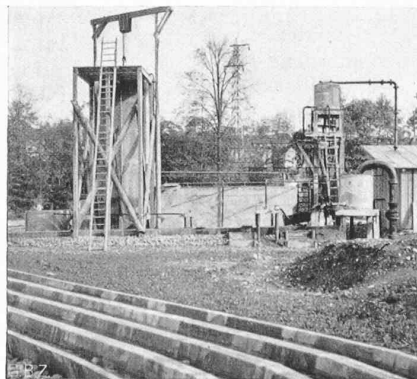
Abb. 2. Gesamtbild der Versuchsanlage.
