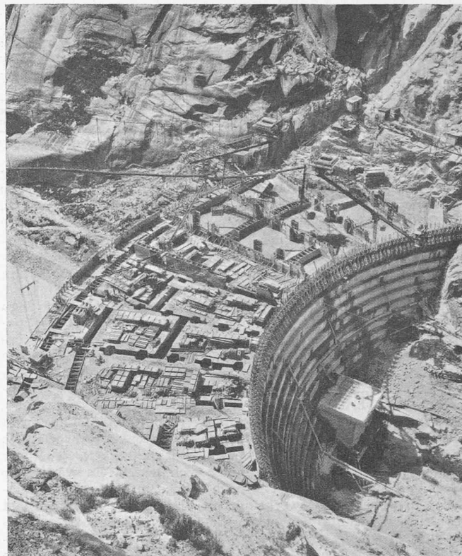
Abb. 3. Bauzustand im zweiten Baujahr, vom rechten Ufer aus.
