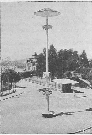
Indirekte Platzbeleuchtung: Ein Rückwirschirm wird von Reflektoren angestrahlt und wirft ein diffuses Licht auf den Platz. Durchmesser der Verkehrsinsel 15 m (vergl. «SEV Bull.» 1934, Nr. 18).
