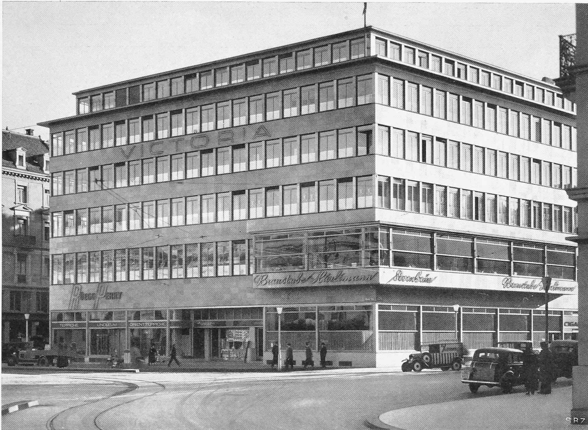
ANSICHT AUS NORDEN : LINKS BAHNHOFPLATZ, RECHTS LÖWENSTRASSE
