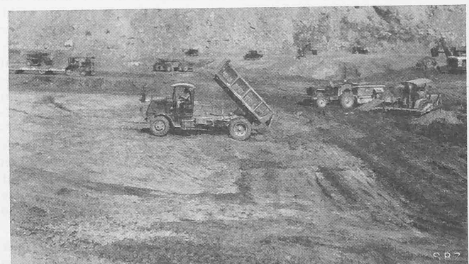
Abb. 9. Mohawk-Damm, Bauzustand im November 1935.
