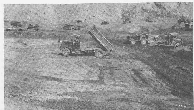
Abb. 9. Mohawk-Damm, Bauzustand im November 1935.
