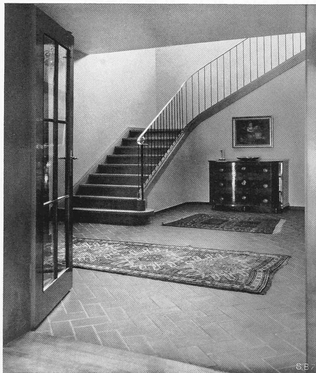
TREPPENHALLE IM ERDGESCHOSS
