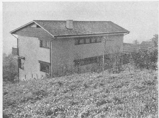
Abb. 11. Die massive Rückseite des Landhauses in Herrliberg von Arch. H. FISCHLI, Zürich.
