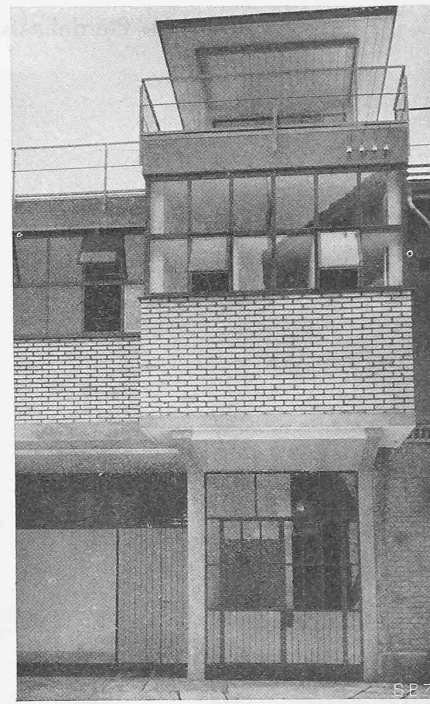
Abb. 12. Treppeneingang und Ausbau für WC.
