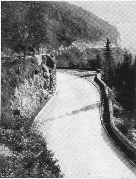
Abb. 5. 11 m breite Strasse bei Mauthäusl.
