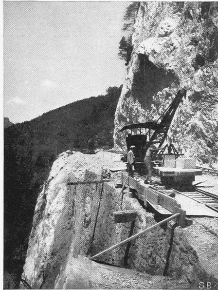
Abb. 6. Baustelle an steilem Felshang (Phot. Todt).
