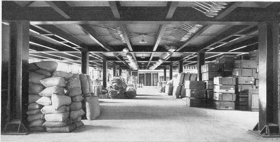
Abb. 6. Erdgeschoss mit Betonboden, oben Holzboden des ersten Stockes.
