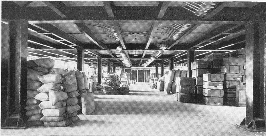
Abb. 6. Erdgeschoss mit Betonboden, oben Holzboden des ersten Stockes.
