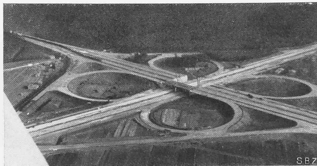
Abb. 10. «Kleeblatt»-Kreuzung (im Bau).
