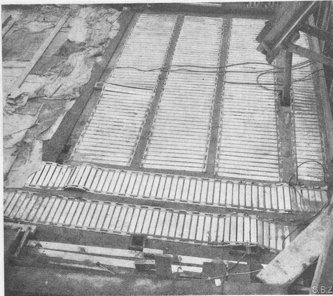
Abb. 7. Elektrodenteppiche beim «Hirse»-Bau, Zürich.
