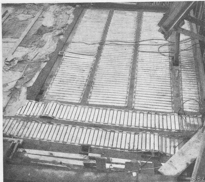
Abb. 7. Elektrodenteppiche beim «Hirse»-Bau, Zürich.
