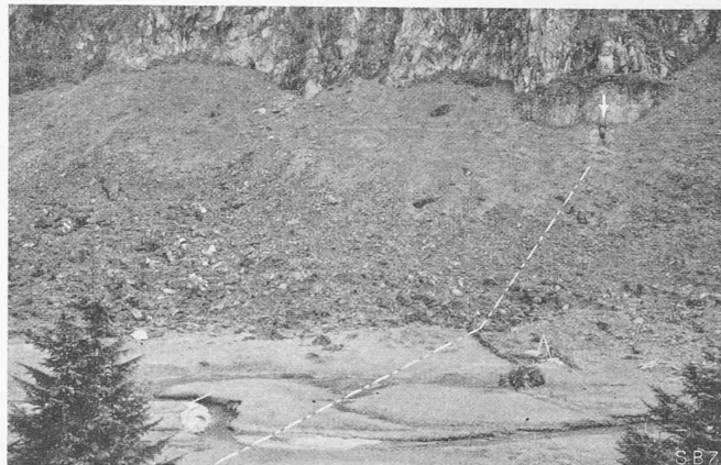
Abb. 4. Ansicht der linksufrigen Schutthalde (mit der Dammxaxe).
