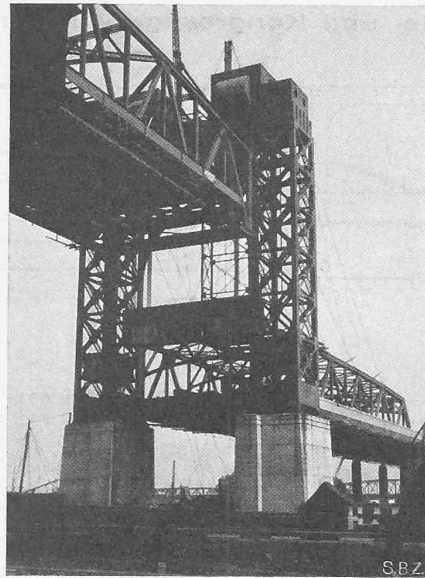
Abb. 6. Die aufgezogene Hubbrücke.
