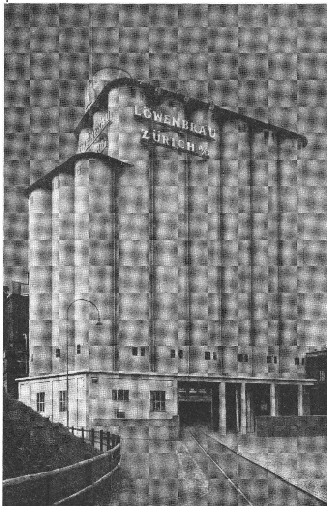
Silo-Anlage von 4500 m 3 Inhalt
