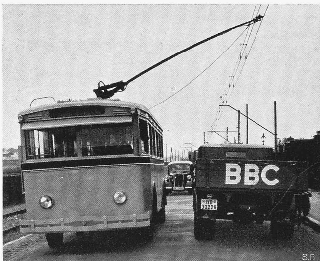
Abb. 14. Einstangen-Stromabnehmer und Vielfach-Aufhängung BBC.
